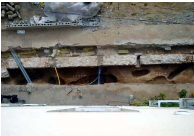
Vista general de la Rasa 4000.
